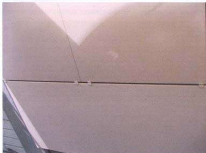
Рис. 2 – Вид зовнішнього оздоблювального шару з керамогранітних плит
