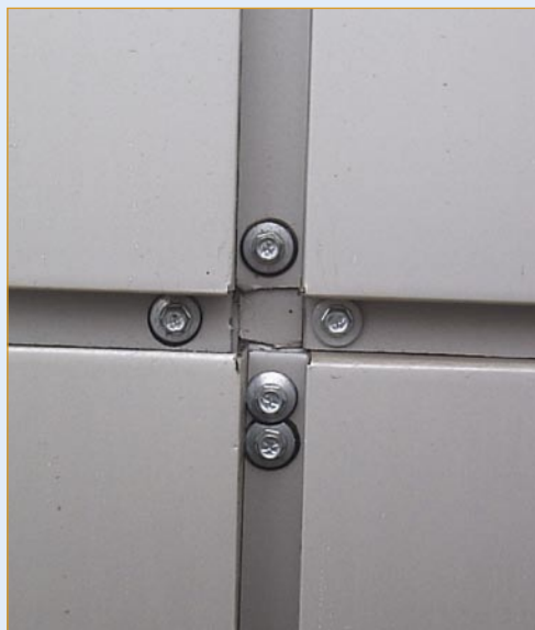
Рис. 4. Пример проблемного, жесткого крепления панелей.
